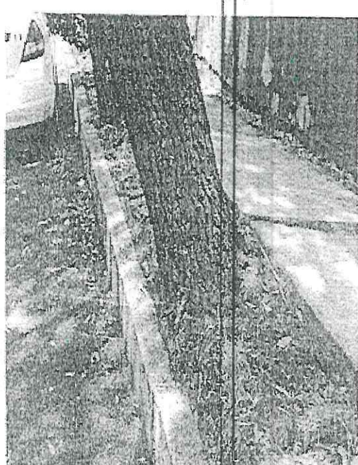
Raíces expuestas que fracturo y levanto banqueteta
